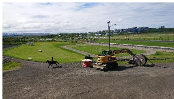
Mynd 3 Frá framkvæmdum fyrir Landsmót
