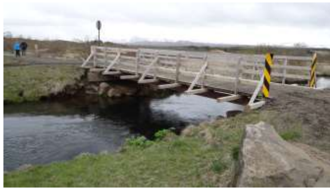
Mynd 6-24 Reið- og göngubrú yfir Bugðu við Norðlingaholt.
