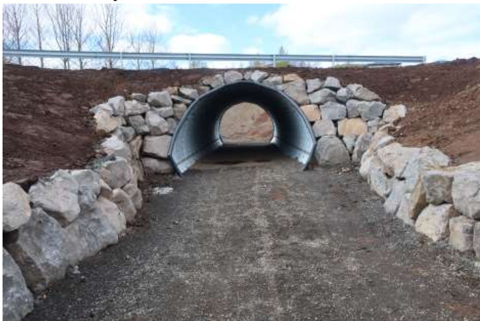
Mynd 6-14 Ný undirgöng undir Reykjaveg í Mosfellsbæ.
