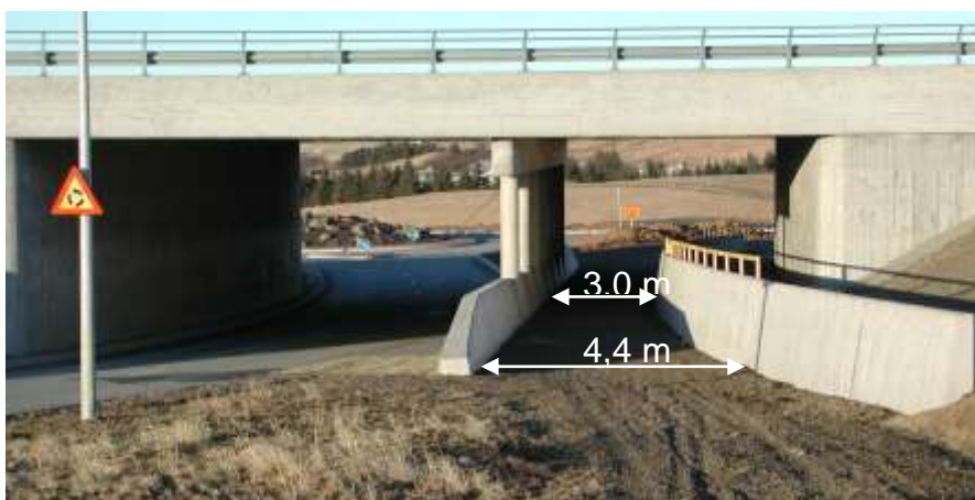
Mynd 6-17 Reiðstígur um Grafargil undir Vesturlandsveg. Minnsta breidd ganga, sem sýnd er á myndinni, er 3 m en breiðkar til beggja enda og er breiddin 4,4 m fremst í undirgöngunum, opið svæði og útsýni gott.
