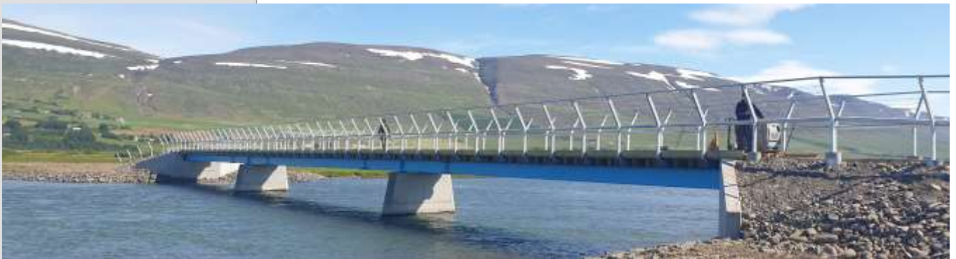
Mynd 6-33 Vesturbrú yfir Eyjafjarðará. Mynd Sigfús Helgason
