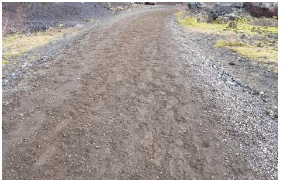
Mynd 9-2 Frágenginn reiðstígur, uppbyggður með styrkingarefni, unnið reiðstígaefni sem slitlag og grjóthreinsaðir fláar.
