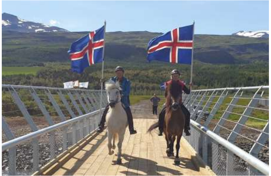
Mynd 6-32 Vesturbrú yfir Eyjafjarðará. Mynd Sigfús Helgason
