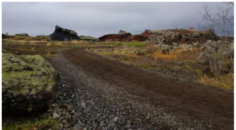
Mynd 5-3 Reiðstígur í Raudhólum, gróft styrktarlagsefni með unnu reiðstígaefni sem slitlag.
