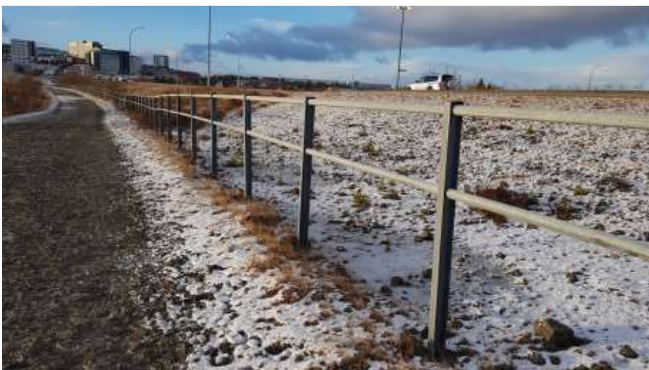
Mynd 6-8 Öryggisgirðing kemur í veg fyrir að hross hlaupi inn á veg. Hæð á efra rör er 1,3 m og lengd milli stólpa 2 m.
